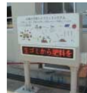
発電量表示パネル
