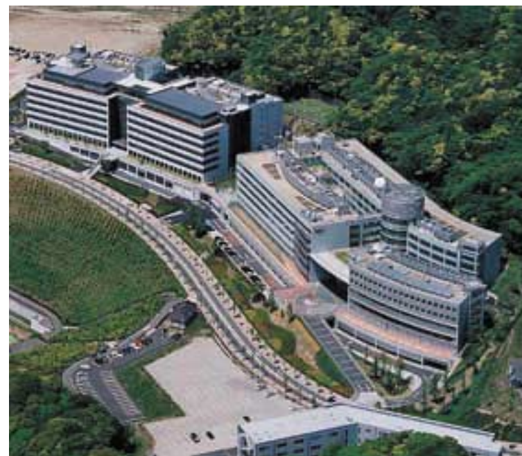
NTTドコモR&Dセンタ2号館(左。右は1号館)
