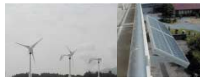
白瀬小学校のハイブリッド発電システム (太陽電池)
