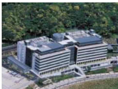
NTTドコモ R&D センタ 2 号館と保存緑地
