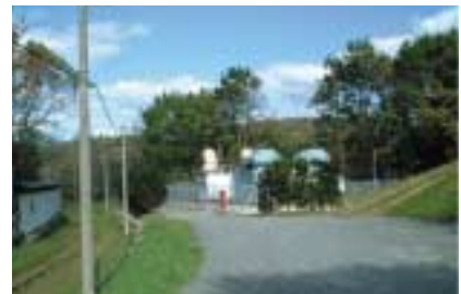
古牧温泉コージェネレーション設備
