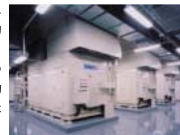
機械室のCGS発電機
