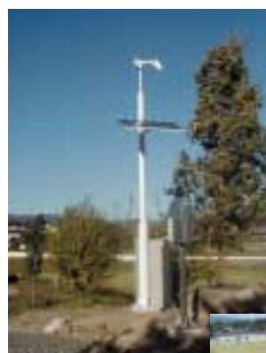
東藤原小学校のハイブリッド発電システム
