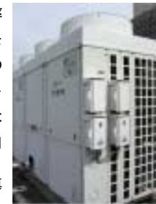
圧縮機コントローラー（写真中央）を取り付けた空調機器
