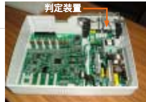
ビジネスホン主装置内に装着した小型シール鉛蓄電池用劣化判定装置
