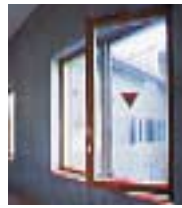
内側が木製の断熱サッシ
