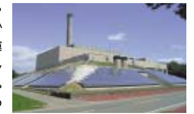
丘の傾斜を利用して太陽電池パネルを設置した「太陽の丘」
