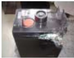
ショートによって焼損したシール鉛蓄電池
