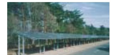
駐車場の日よけを兼ねた太陽電池パネル
