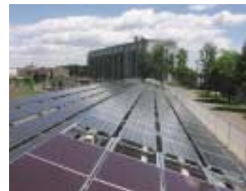
6仕様・4種類の太陽電池パネルを1か所に配置した「太陽光発電パビリオン」
