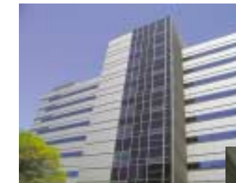
建物のガラス面を利用して設置した薄型太陽電池パネル
