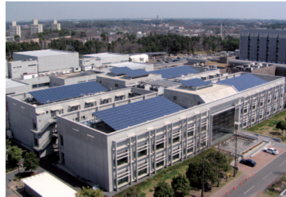
つくば市にある産業技術総合研究所の太陽電池
