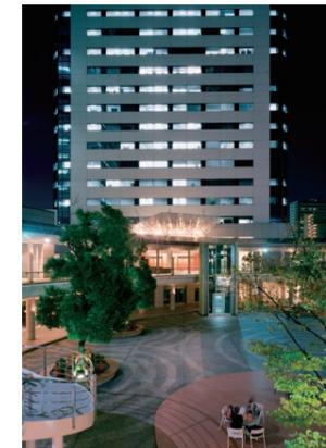
火災に対しては避難安全検証や耐火性能検証など科学的なシミュレーションを行い、地震に対しては制震構造を採用、さらに雷害対策として新JIS規格を適用し、外部雷保護システムの構築により安全性の高いオフィスビルを実現しました。
