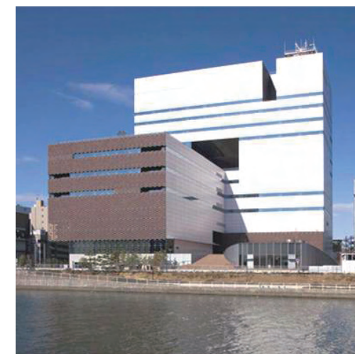
クールシティ中枢街区パイロット事業となった朝日放送新社屋
