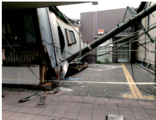
電柱の折損
