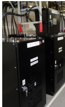
通信ビル向けHVDC給電用リチウムイオン蓄電池
