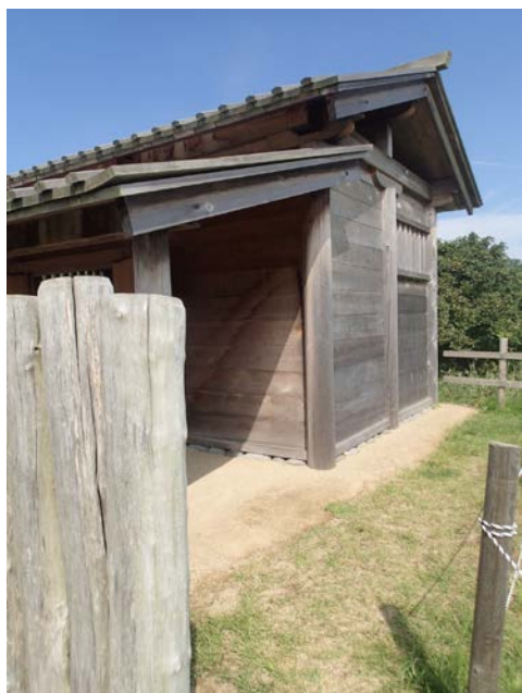
写真1 秋田城トイレ建物
