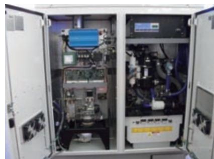
図15 5 kW 出力のメタノール燃料電池 (固体高分子式) (IdaTech 社)
