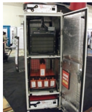
図12 展示されていたリチウムイオン電池 (写真のラック上およびラック最下段に設置。48V, 180 Ah, EnerSys社)
