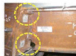
梁端フランジの破断
