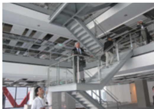
写真2 3層の床を結ぶ階段
