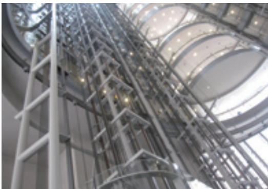
写真4 自然換気のための吹抜け
