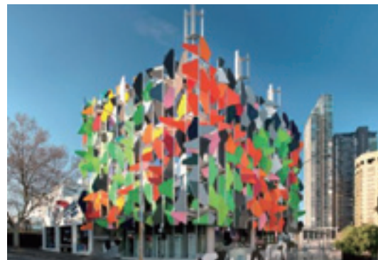
写真6 日射調整のためのカラフルなフィンで覆われた外観
