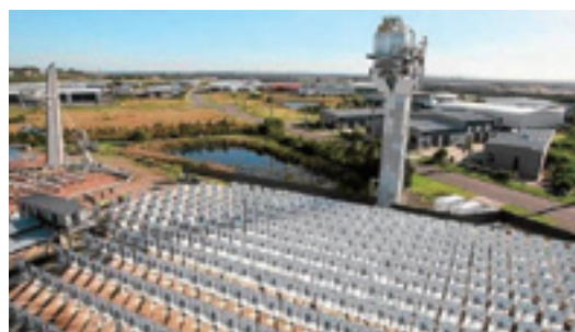
写真9 太陽光集熱装置（ヘリオスタット）とレシーバ。多数の鏡を並べたヘリオスタットによる集熱温度は3,000度となり、加熱処理により蒸気は850度になる
