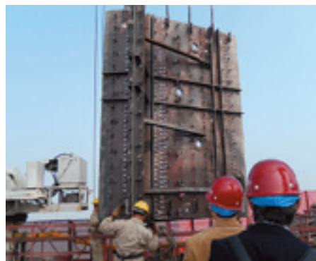
写真6 現場見学・鋼板壁の建て込み
