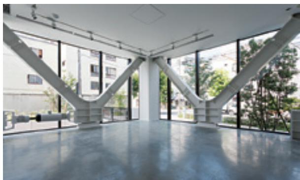
写真3 低層鉄骨制振建物の制振デバイス
