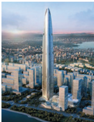
写真4 武漢緑地センタービルのパース (塔体隅角部に風穴があることがわかる)
