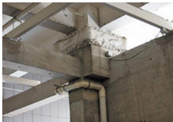
写真20 地下1階免震層と免震支承耐火被覆
