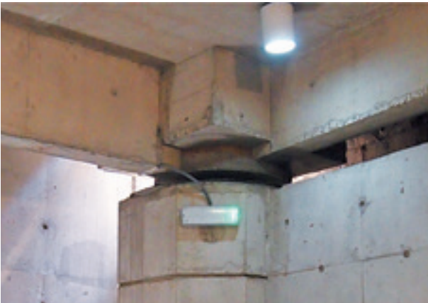
写真10 側柱部分は地下1階で柱頭免震
