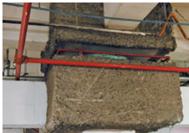
写真8 積層ゴム支承の耐火被覆と散水用配管
