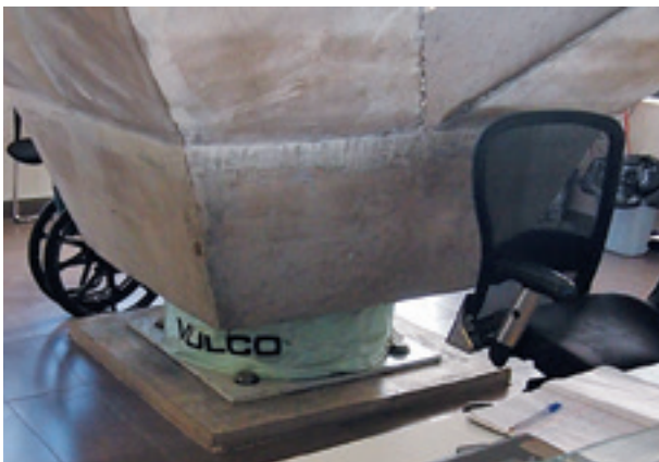
写真23 事務室内に設置された積層ゴム支承
