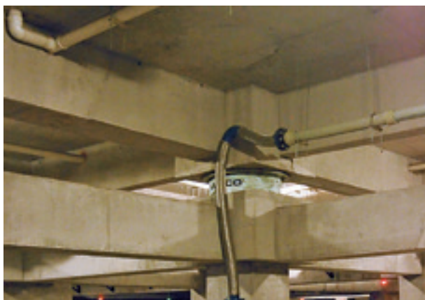
写真16 地下1階免震層と設備配管フレキシブルジョイント
