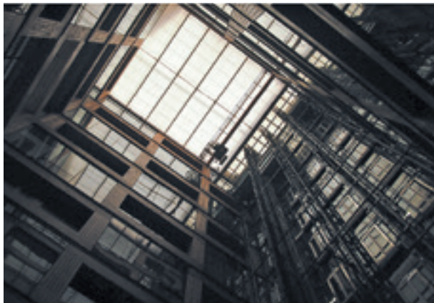
写真15 内部アトリウム
