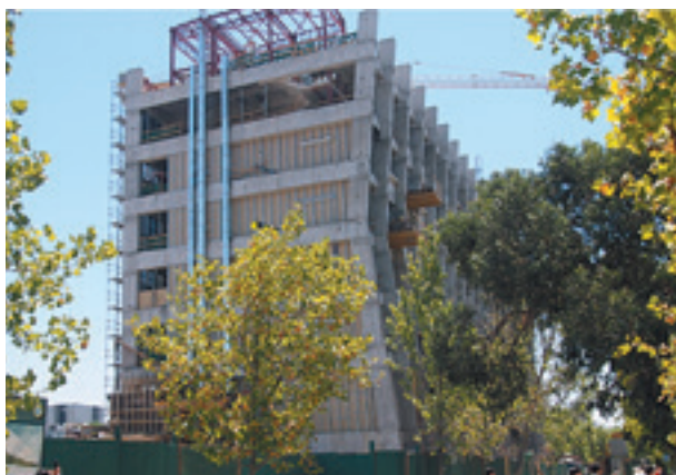
写真17 The Science and Technologyの外観
