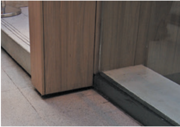
写真21 建物内部エキスパンションジョイント
