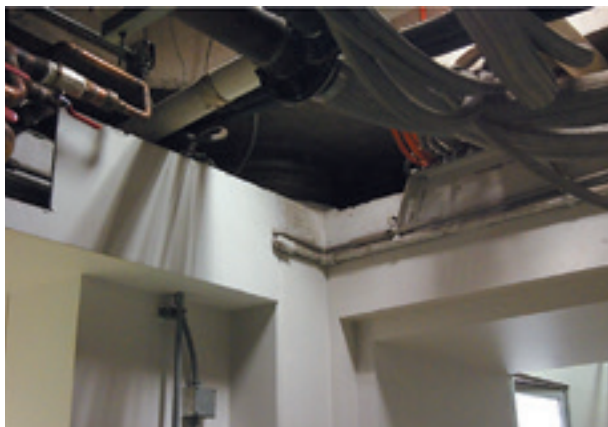
写真3 免震層と設備配管のフレキシブルジョイント
