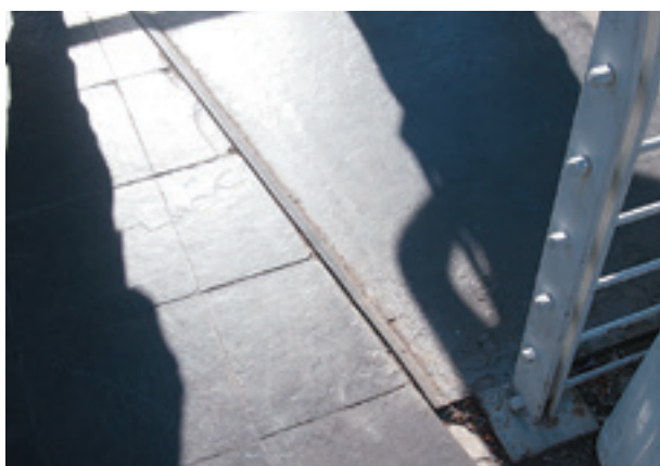
写真2 病院入口デッキ部のエキスパンションジョイント
