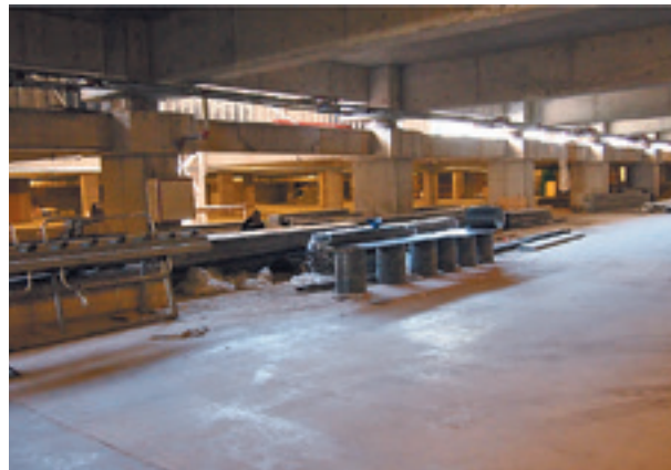
写真18 地下1階免震層
