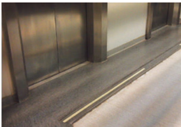
写真4 地下エレベータホールのエキスパンションジョイント
