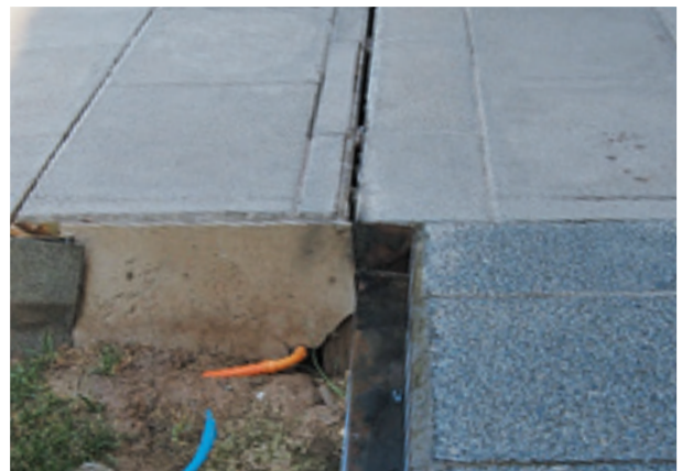
写真14 外構部分のエキスパンションジョイント
