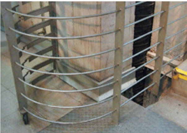
写真11 建物内部エキスパンションジョイント
