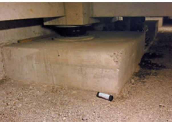
写真12 中柱下は基礎免震
