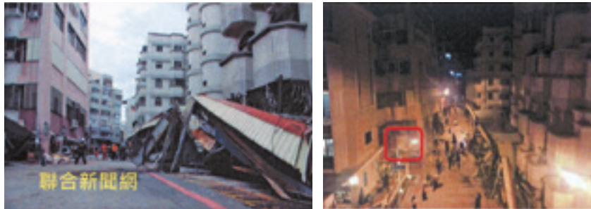
写真7 花蓮地震における2つの建物被害 7)
