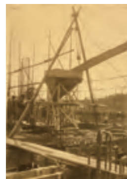
写真5 施工中の現場写真
