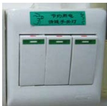
写真1 某施設における節電取り組み例 (照明スイッチのこまめな消灯を励行している)
