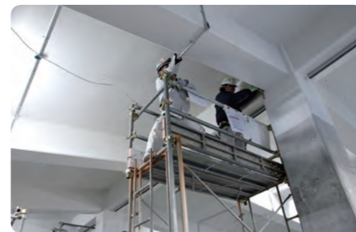
新 NTT 七ヶ浜ビルの内部工事状況
