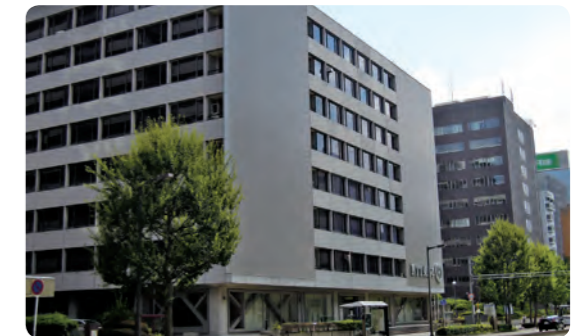
外壁を改修した五橋第一ビル
