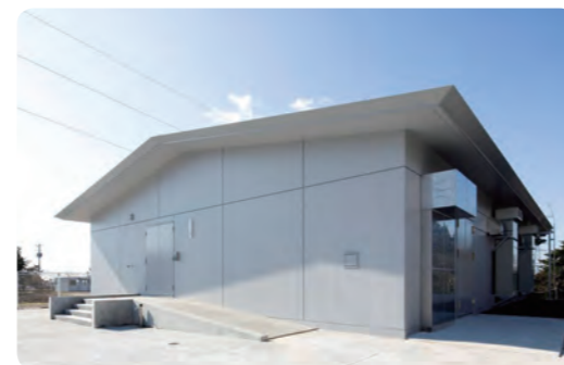
新 NTT 七ヶ浜ビルの外観
